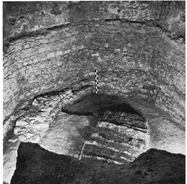
Freihof Löwenburg. Inneres der Kirche mit Mauerwerk aus Periode 2 und Balkenniveau
