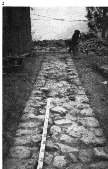
Bild 2 Quermauer zwischen Raum B und C Außen gehauene Tuffsteine Innen Sandsteinbrocken
