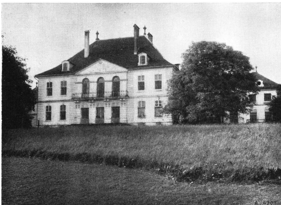
Schloß Hindelbank, Nordfassade
