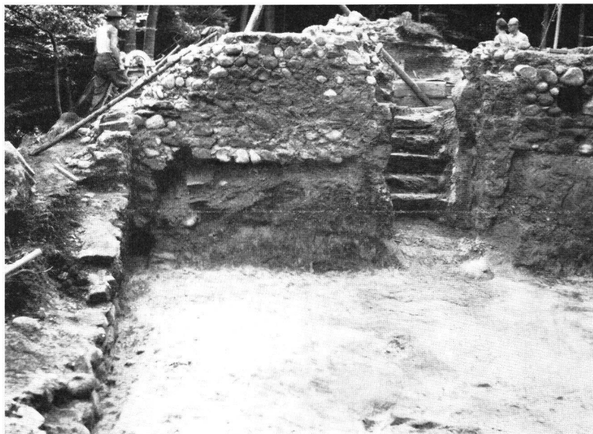
Oben: Rest der «Schildmauer» auf abgeschrotetem Nagelfluhfels, Hasenburg. Unten: Mauer des Hauptgebäudes auf abgeschrotetem Sandstein, Hasenburg Photo G. Evers
