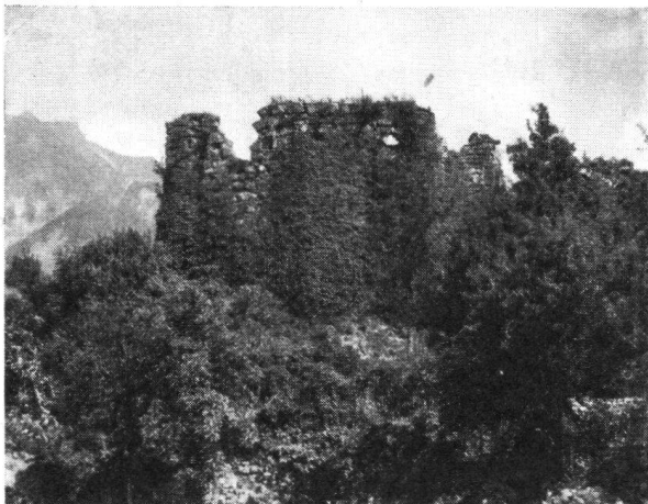
Die vollständig von Efeu umspinnene Ruine Forstegg vor der Restaurierung
