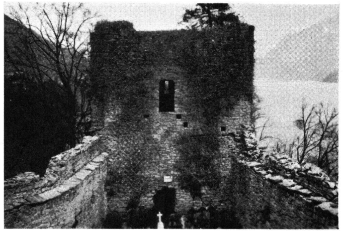
Wohnturm A nach Entfernung des Efeus. Man beachte den bloßgelegten Wehrgang der Ringmauern.
