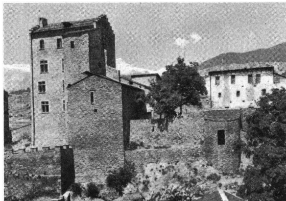
La Façade sud
