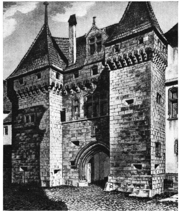
Abb. 7. Alter Zustand vom Haupttorbau des Schloßes Neuenburg
