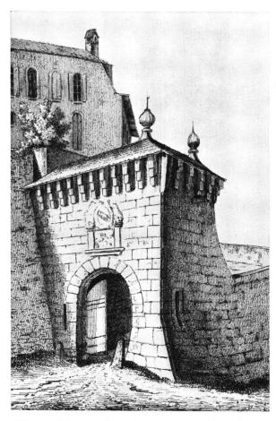
Abb. 2. Aubonne. Über den steinernen Konsolen war vielleicht nur ein hölzerner Wehrgang aufgesetzt, wie beispielsweise bei der berühmten Porte de Laon in Coucy-le-Château (leider im ersten Weltkrieg zerstört) oder aber ein steinerner Wehrgang analog dem Tor in der kleinen Stadt Flavigny (Côte-d'Or).
