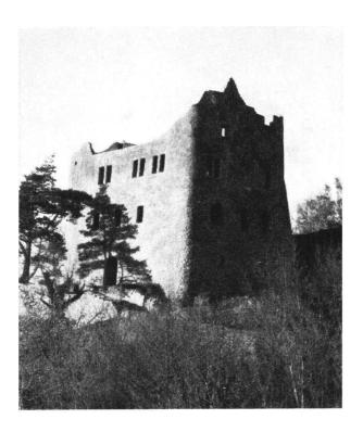
Der Wohnturm der *Homburg* nach der Restaurierung. Aufnahme 1942. Die Mauern werden bei dem verwendeten Bindemittel (Kalk statt Zement) bald wieder Patina ansetzen.
