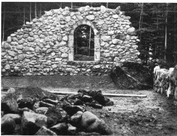
Ruine Bernegg. Partie mit der ausgegrabenen und wiederhergestellten Tür zwischen A und B (s. Plan)
