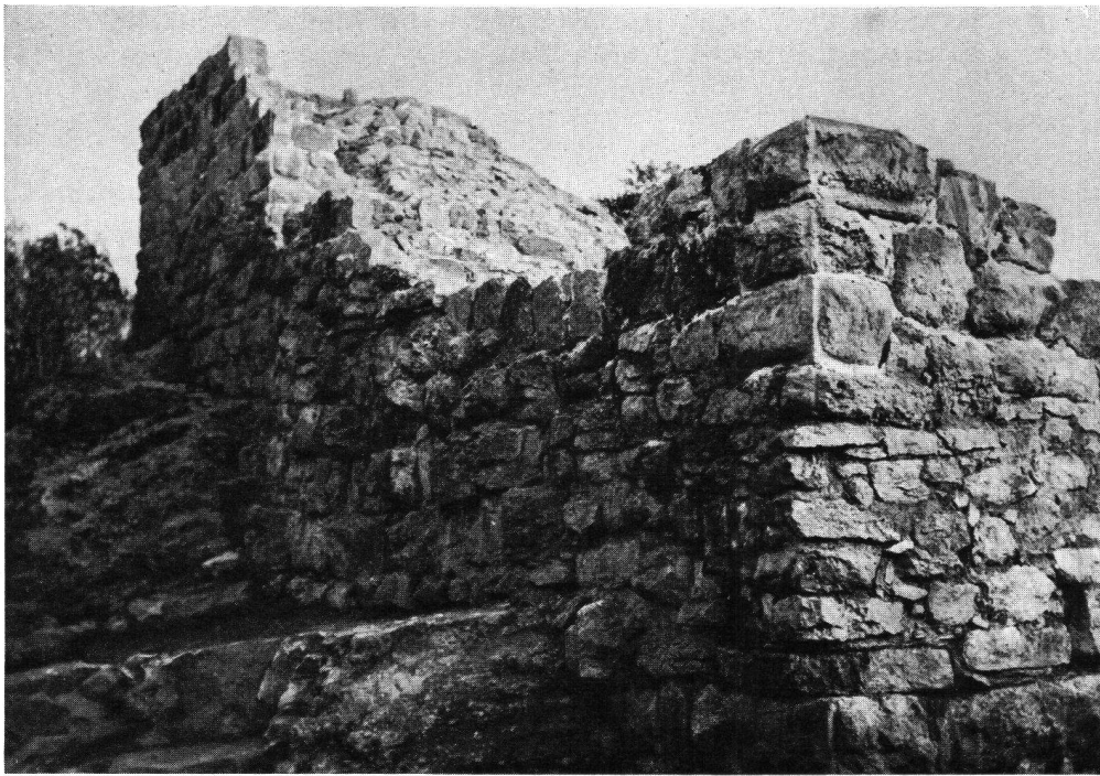
Radegg: Blick auf die Nord- und Westseite der Ruine mit den Resten des Bergfriedes (links) und des Wohnturmes (rechts)
