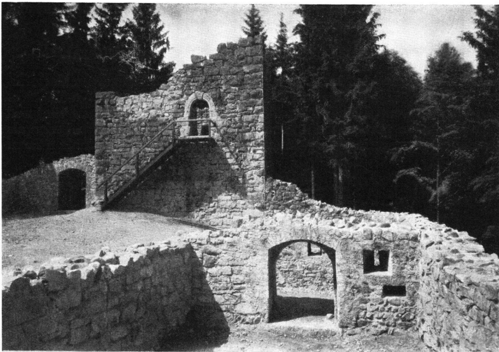
Rosenburg nach der Ausgrabung und Sicherung des Mauerwerkes
