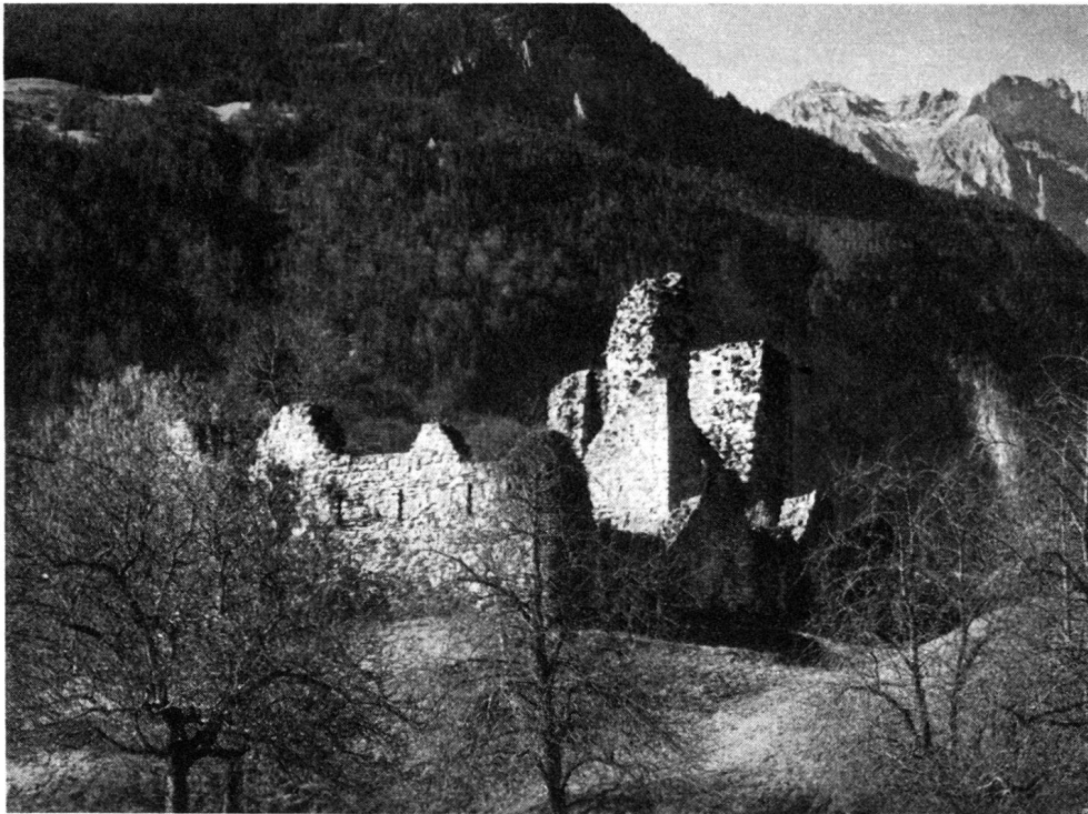
Die Ruine Attinghausen in ihrer heutigen Umgebung und vor Errichtung des Käsereibebäudes und der Schweinemästerei
