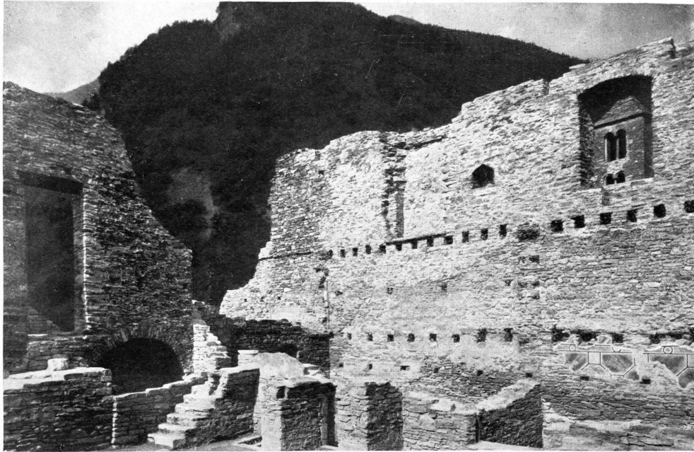
Die vor weiterem Verfall geschützte Ruine Misop. Ausgegrabene und gesicherte Teile des Palas mit Resten von Wandmalereien. Durch das Fenster Blick auf den Campanile.
