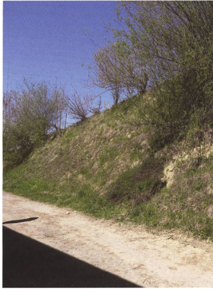
Fig. 29 Blick zum abgetragenen Hang. (WIDER 2012)
