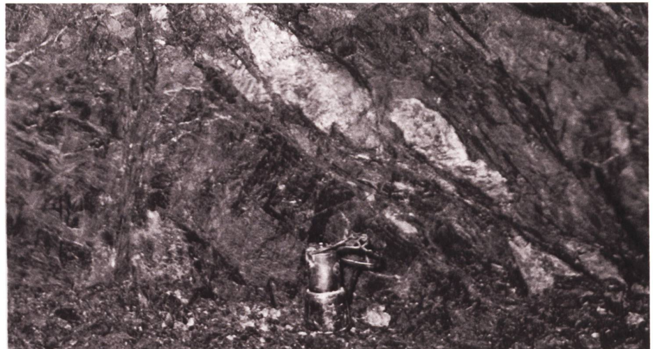
Nr. 13 13.10.55 Stollen Tgom Seitenstollen bei 132.0m Brust. Detail bei 23.0m weiss Quarzlinser.
