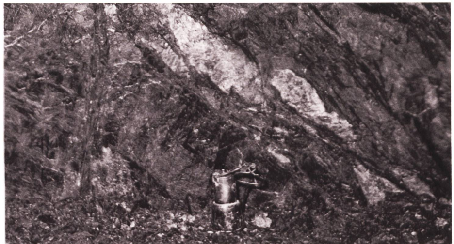
Nr. 13 13.10.55 Stollen Tgom Seitenstollen bei 132.0m Brust. Detail bei 23.0m weiss Quarzlinser.
