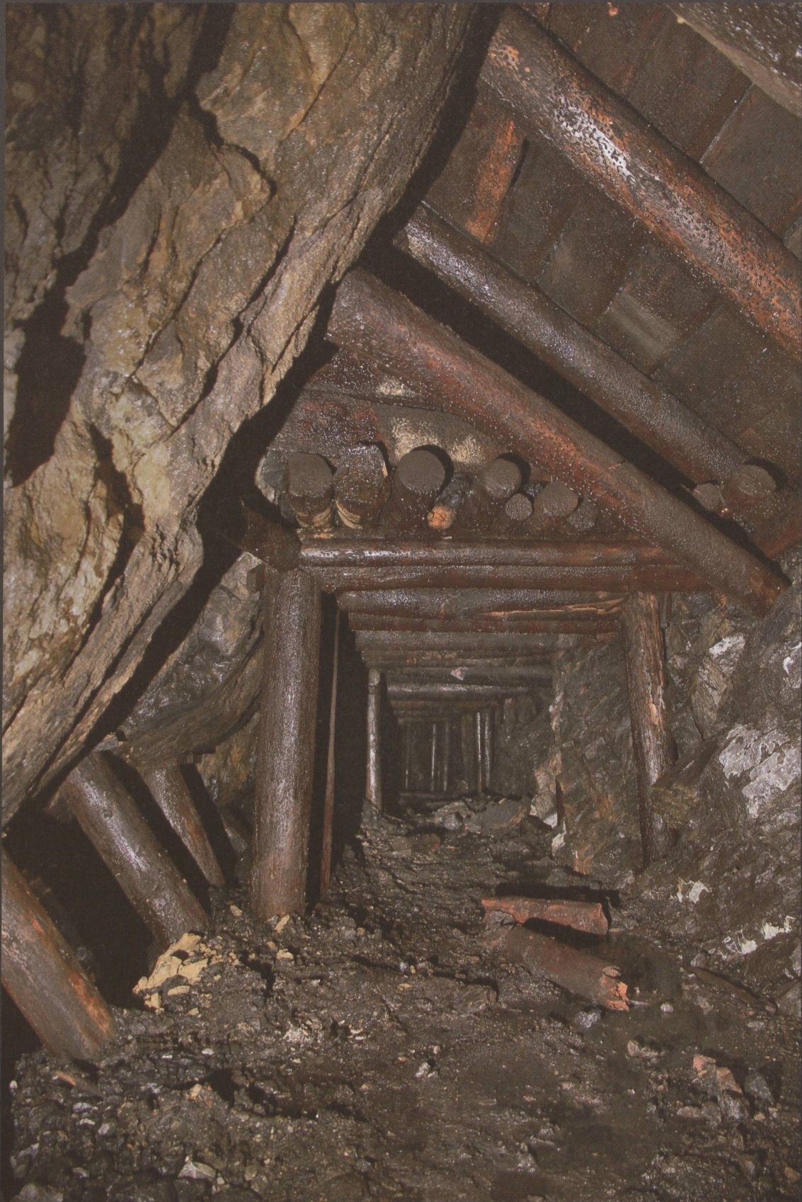
Stabile Holzzimmerung im Bergwerk Schlafegg
