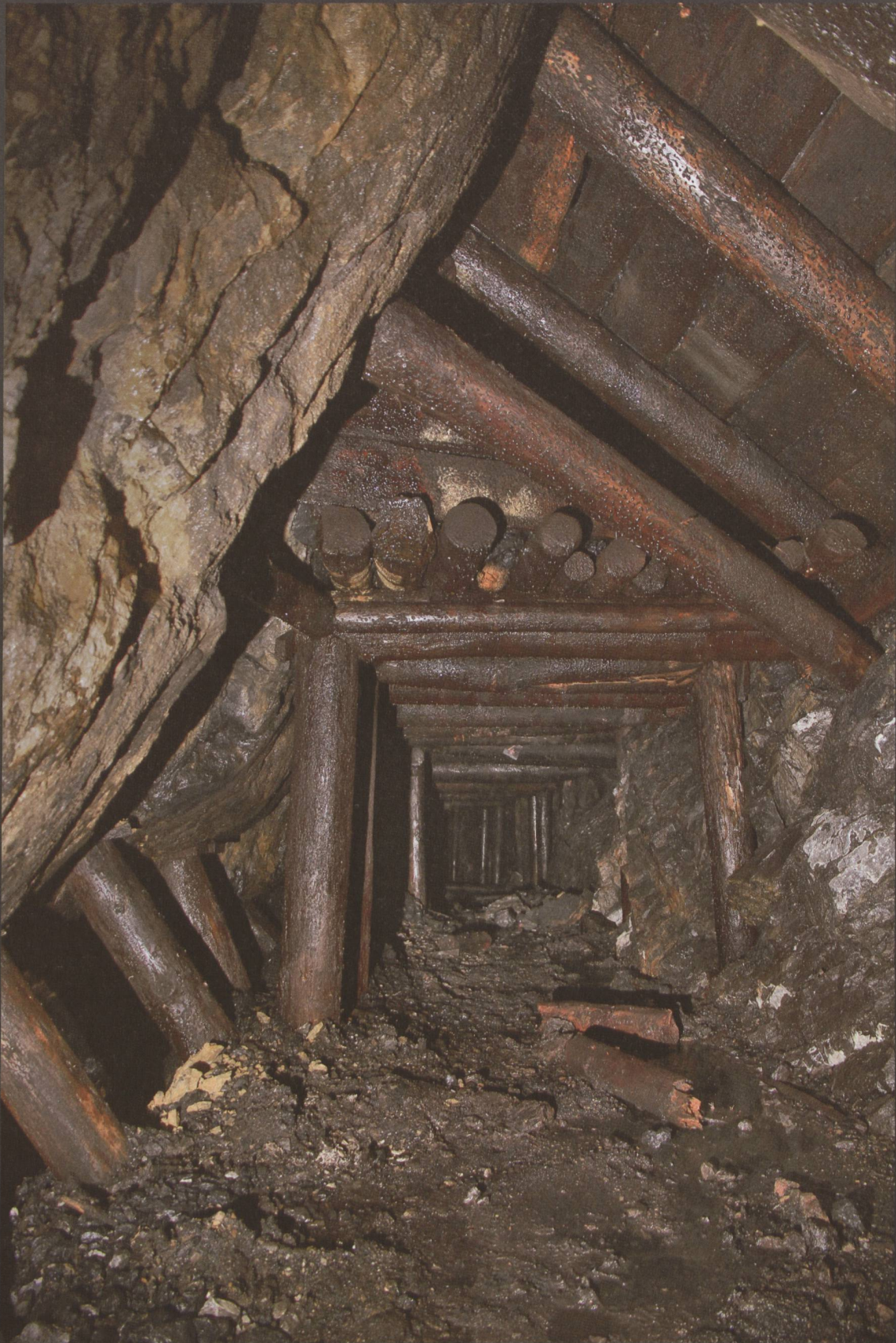
Stabile Holzzimmerung im Bergwerk Schlafegg
