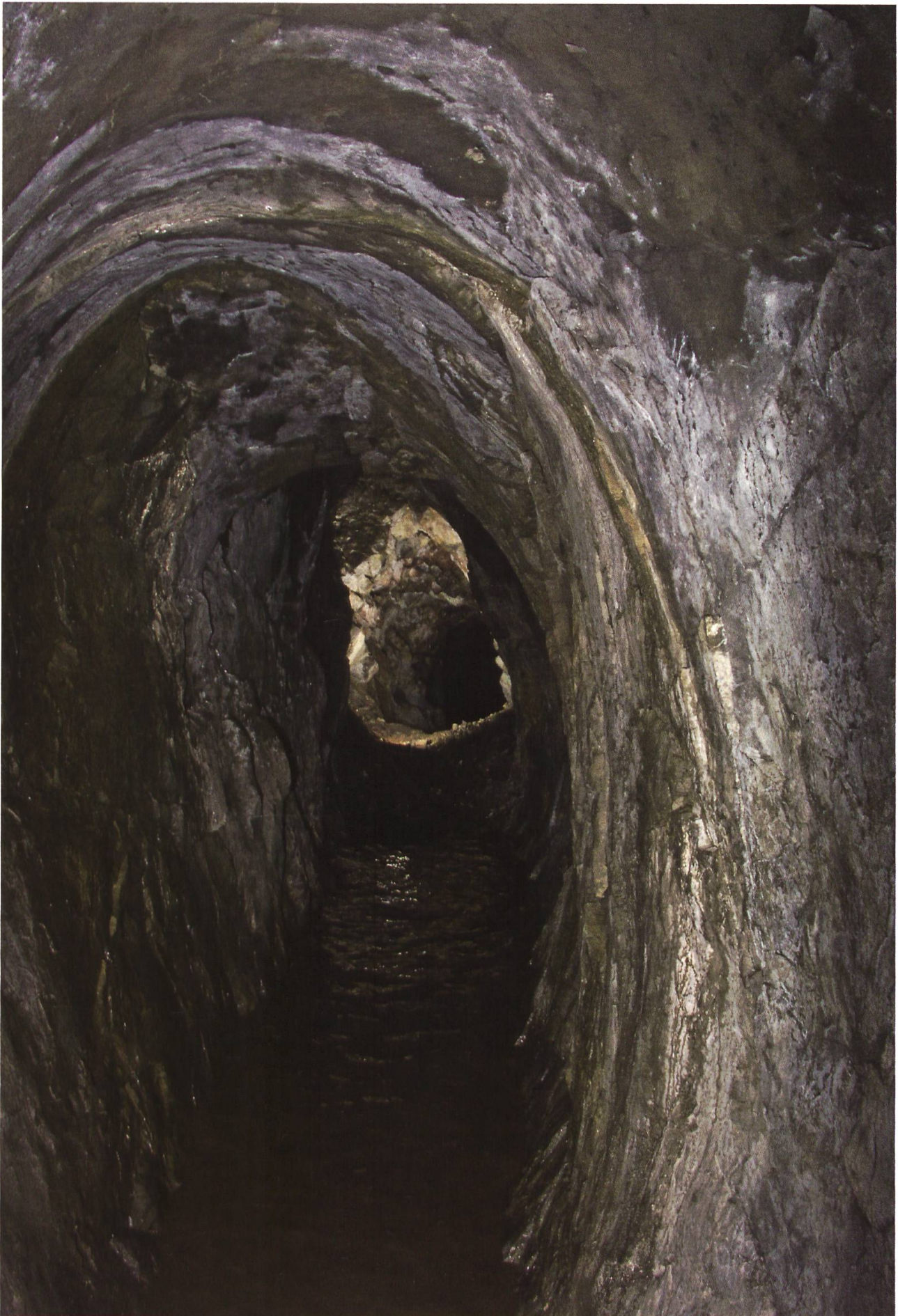
Tiefstollen Silberberg Davos
