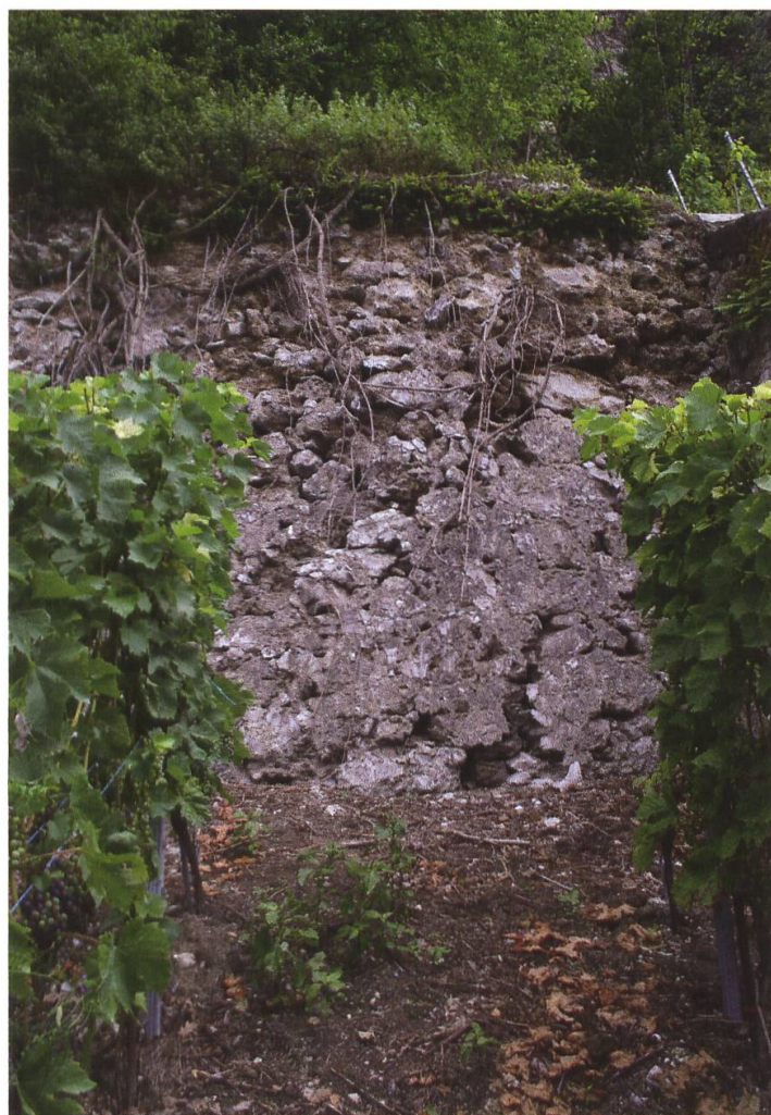
Fig. 16. Mur de vigne en gypse, Ollon.
