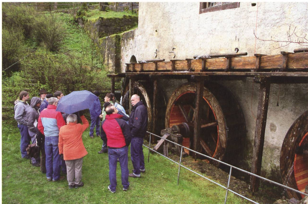
Fig. 3. Die drei überschlächtigen Wasserräder der Mühle.
