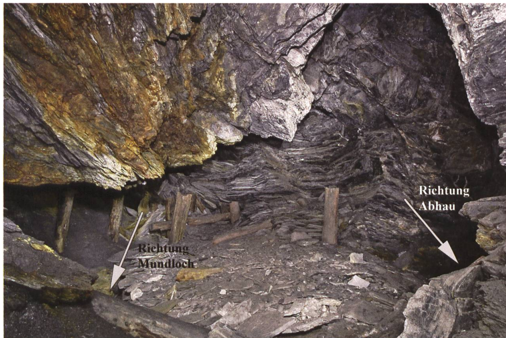
Fig. 16. Versturz an der Kreuzung Lüftungstollen und Hauptstollen (Pkt.9).
