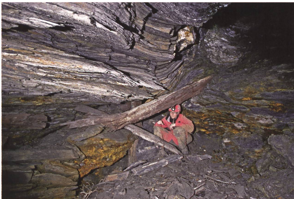
Fig. 18. Ein Gefährlicher Durchschlupf Richtung Hauptstollen bei Pkt. 11.
