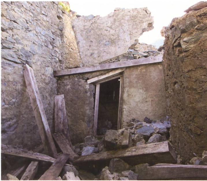
Fig. 1. Bergwerksgebäude in Kaltenberg. Durch die Senkung im Untergrund entstanden schwere Schäden am Mauerwerk.
