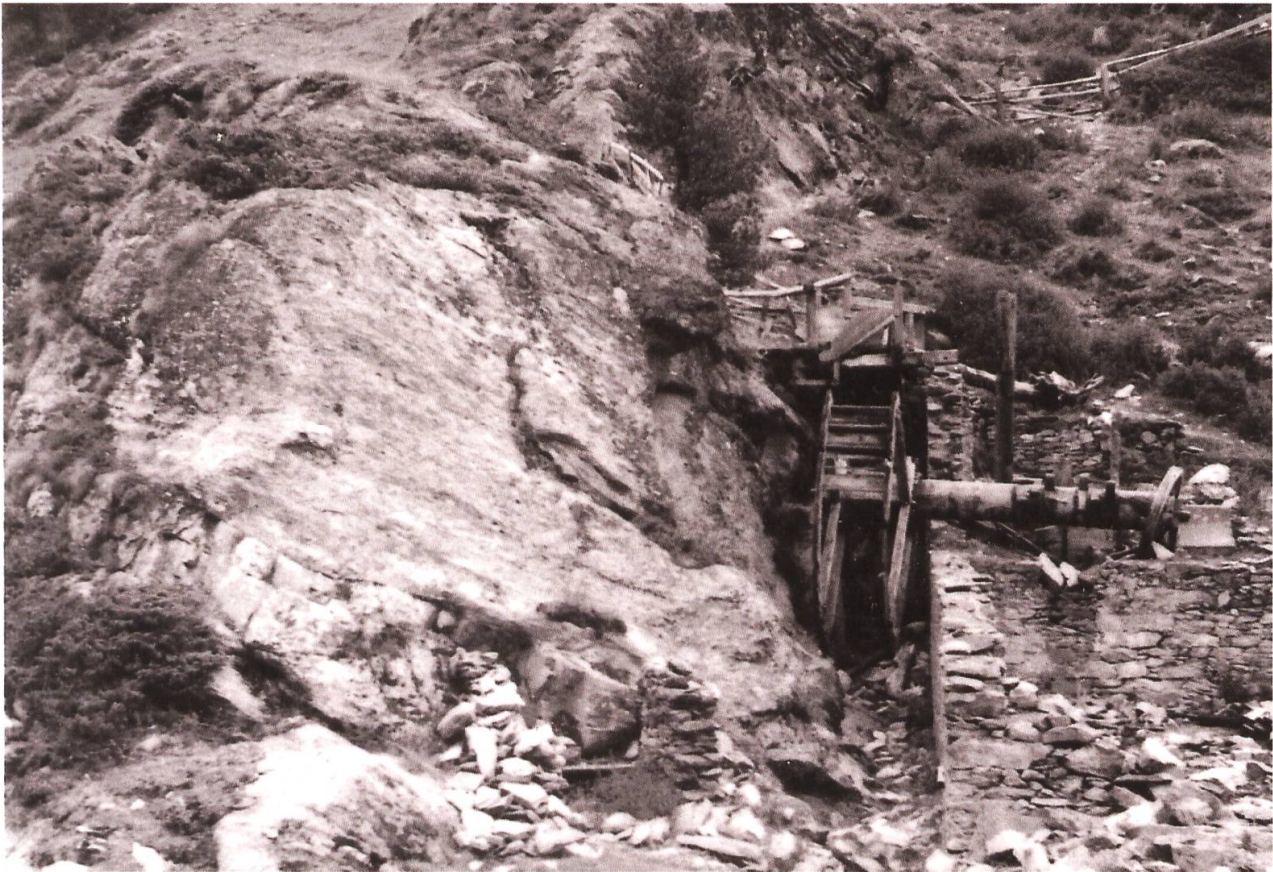
Fig. 13. Foto vom Wasserrad und der Zapfwelle. Das Wasserrad wurde überschlächtig beschickt. Gut sichtbar noch die in die Welle eingelassenen Zapfen (Heblinge). Diese bewegten die sechs Pochstempel im darunterliegenden Pochtrog. Foto: Prior Johann Siegen, Kippel, undatiert, vermutlich 1950er Jahre. Sammlung Untergrund Schweiz, Bergbaumuseum in Ried / Lötschental.
