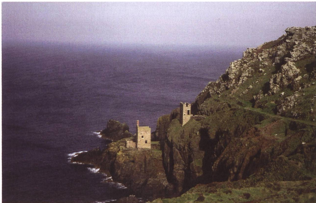
Fig. 6. Maschinenhäuser der Botallack Mine (bei St. Just), unten: «Pumping house», oben: «Winding house» (S.W. Meier 2005).
