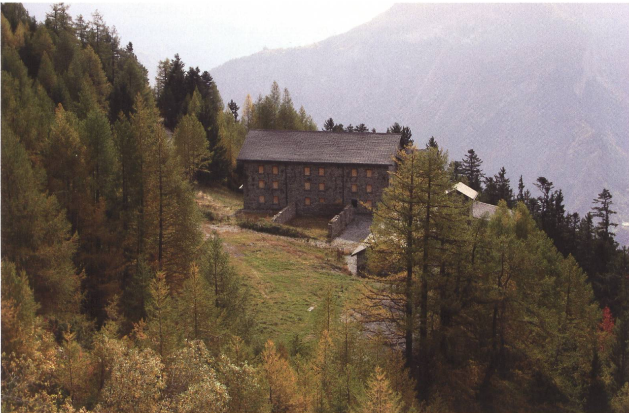
Fig. 3. Erhaltenswerte Gebäude beim Plateau von La Méreune (Foto R. Widmer).
