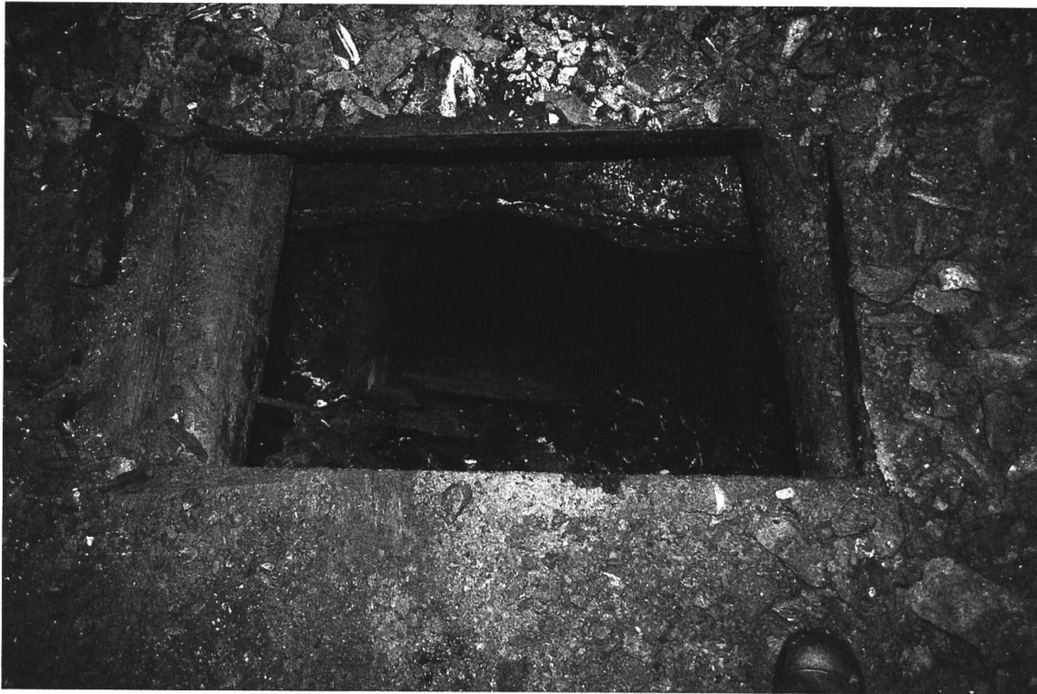
Schrägschacht vom Boden in einer Abbau mit Resten einer Fahrt.
