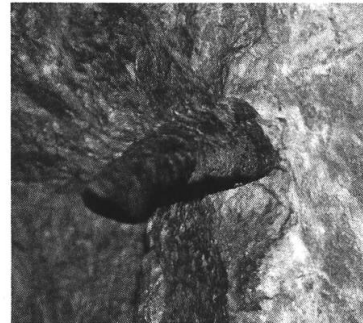
Die Sprenglöcher wurden von Hand gebohrt. Durch das abwechslungsweise Schlagen und Drehen des Bohrmeissels entstanden meistens drei- oder viereckige Löcher. Diese wurden ca. 1.5 m tief gebohrt und mit Schwarzpulver gefüllt.
