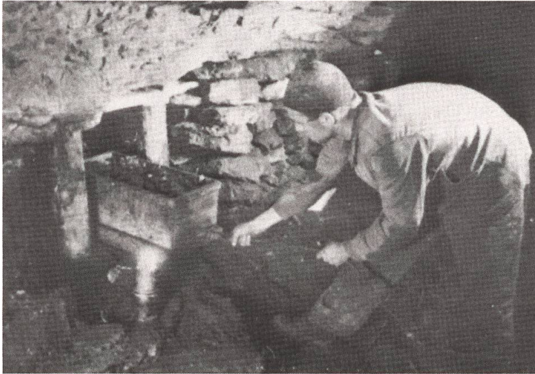
Abb. 14: Ein Bergmann zieht die durch den Hauer gefüllte Holzkiste in den Förderstollen. Das Bild stammt aus dem Bergwerk Horgen und illustriert auch die Abbautechnik auf Beatenberg.
