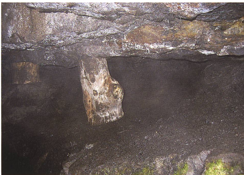
Abb. 15: Brunnenstollen. Abbaufeld mit Flöz im Hintergrund. Der Stempel wurde bei den Sanierungsarbeiten 2005 erneuert (Foto U. Wenger).
