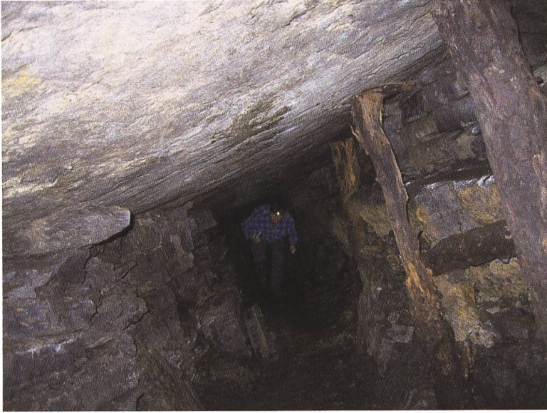
Abb. 10: Oberbergstollen. Rechts ein paar alte Stempel und Versatzeinbauten (Foto R. Kündig).
