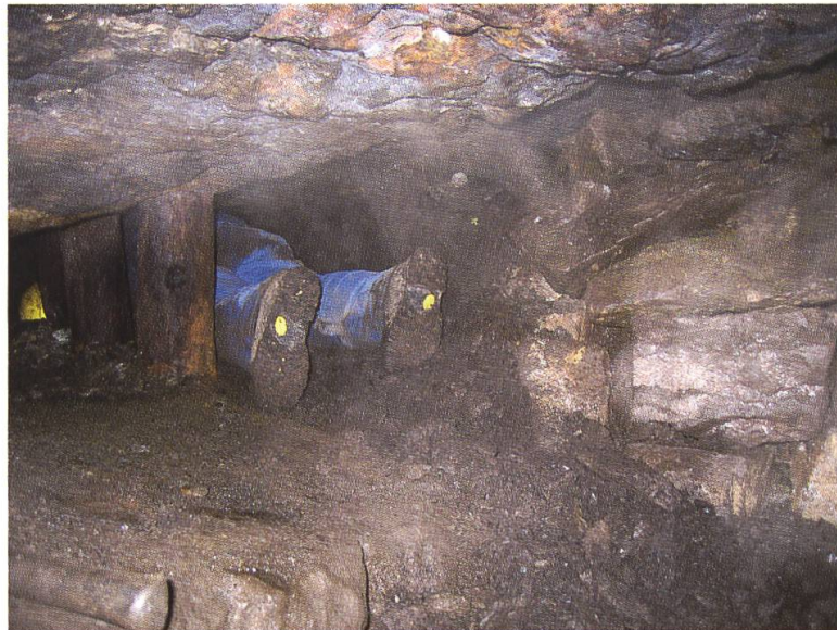
Abb. 17: Sanierung im Brunnenstollen – bis in den hintersten Winkel (Foto R. Kündig).
