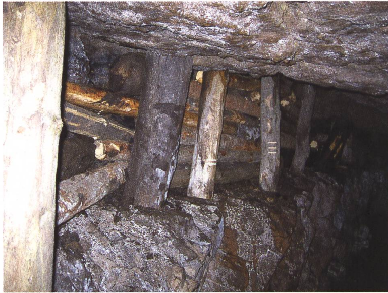
Abb. 21: Jägerstollen. Im Zuge der Sanierung neu verbaute Strecke (Foto R. Kündig).
