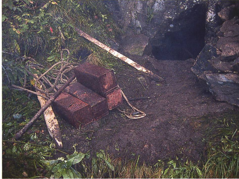
Abb. 16: Brunnenstollen zu Beginn der Sanierung, 2005 (Foto U. Wenger).
