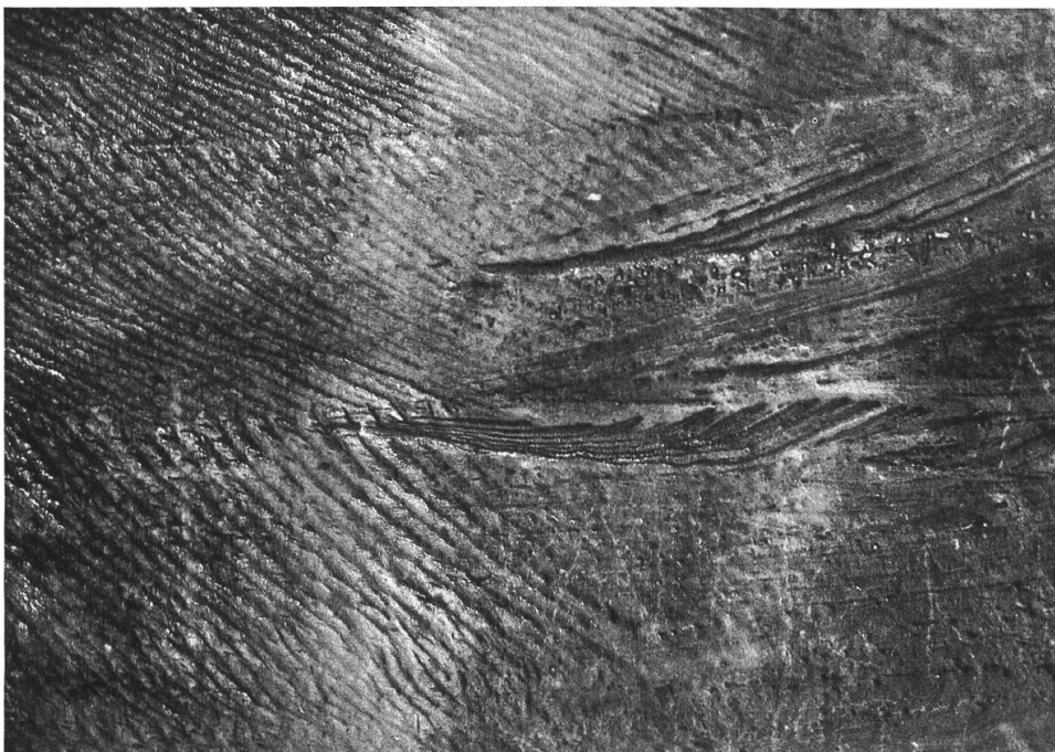
Werkzeuge (Schrämhauen, Meissel) und Abbauspuren im Berner Sandstein (Steinbruch bei Krauchthal).
