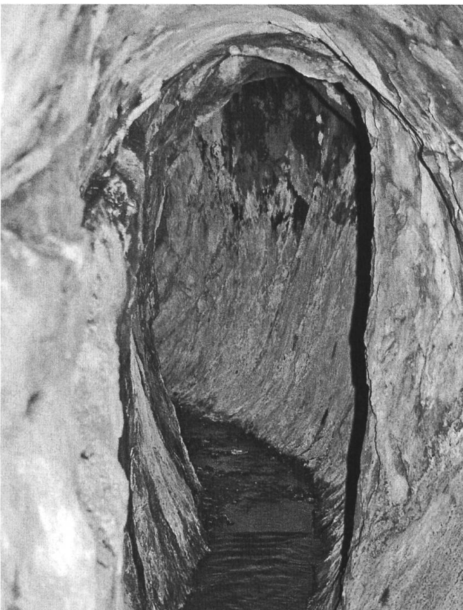
Abb. 12: Stollenquerschnitt IV. Blick von aussen gegen die Richtungsänderung.
