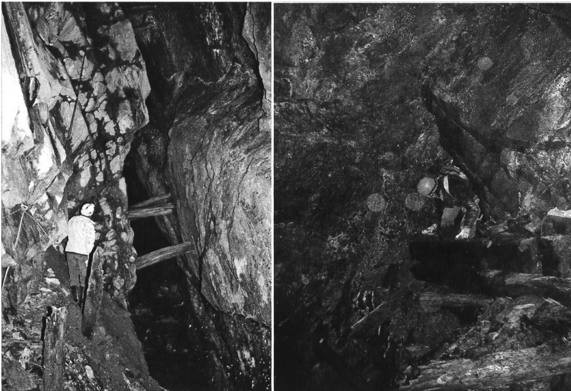
Abb. 14 und 15: Am Übergang vom Vorstollen zum Dalvazzerschacht und Tiefenstollen (Bild 14 P. Kuhn). Bild 15 zeigt den Standort mit Blickrichtung zu Bild 14 und Bild 16.
