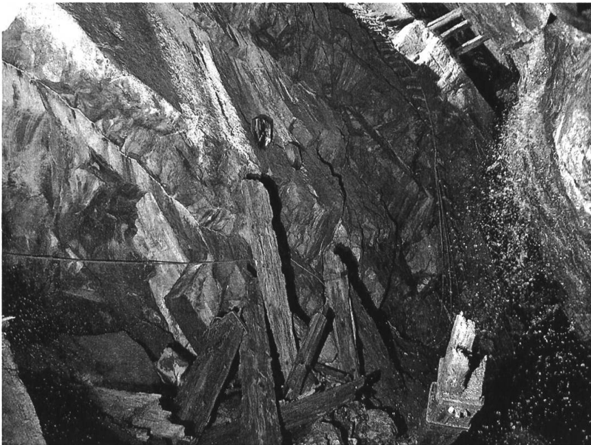
Abb. 16: Blick von unten ins Gewölbe des Dalvazzerschachts.
