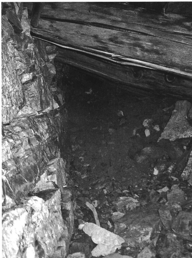
Abb. 6b (oben links): Firstgewölbe in Trockenmauerung nach dem Räumen.
