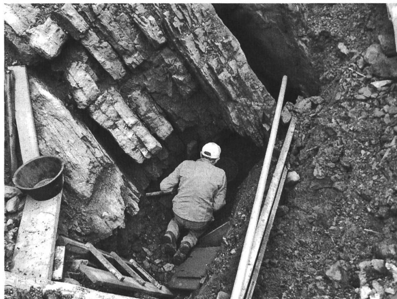
Abb. 7: Mit dem Zwischenangriff «Margo» wurde das alte Mundloch freigelegt. Die Stangen zeigen auf den Felskanal, durch welchen die «Röhre» verstopft wurde.
