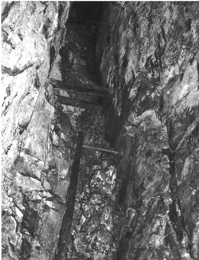
Abb. 11a: Zerstörte Fahrten im unteren Teil des Schrägschachtes (F).
