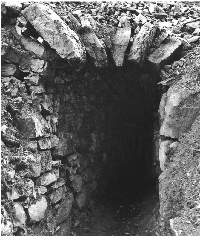
Abb. 6a: Mundloch der Röhre des Vorstollens 19. Jahrhundert mit Firstgewölbemauerung.
