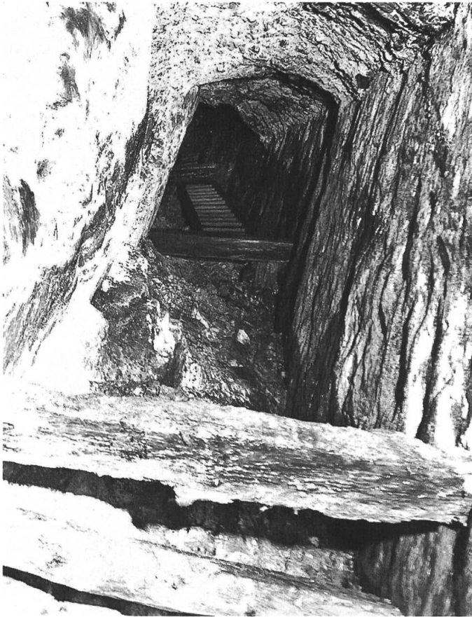
Abb. 11b: Gut erhaltene Fahrten im oberen Teil des Schrägschachtes (F).
