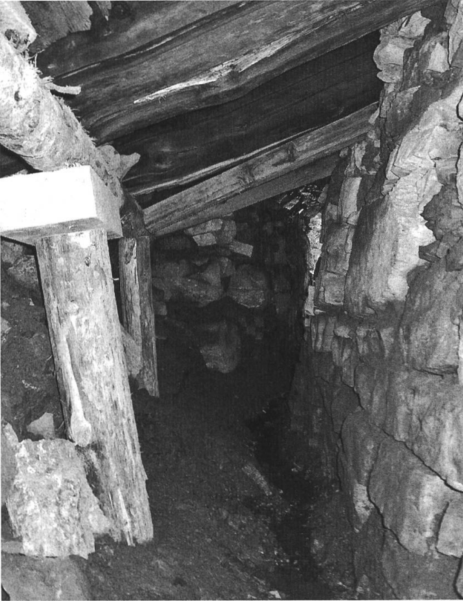
Abb. 8: Röhre geräumt und provisorisch gesichert Blick von innen (Stollenquerschnitt I).
