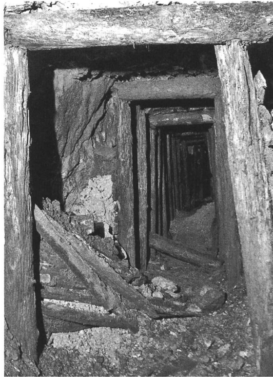
Abb. 8: Alte Zimmerung im Neuhoffnungsstollen
