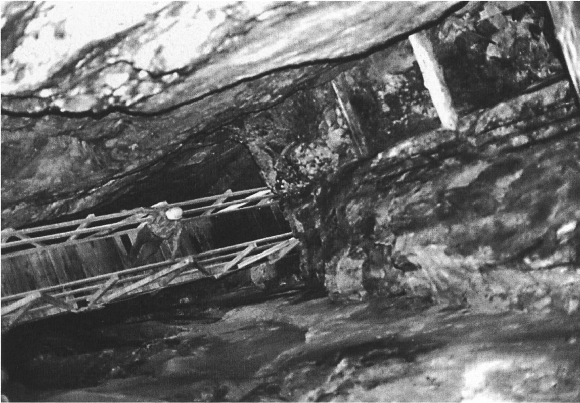
Abb. 1: Blick von oben auf die Brücke im Dalvazzerschacht
