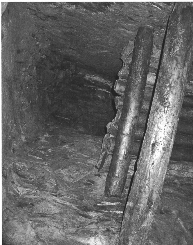
Abb. 6 : Blick in den unvollendeten Schacht mit Arbeitsbühne, am Ende des Hilfsstollens St.Michael
