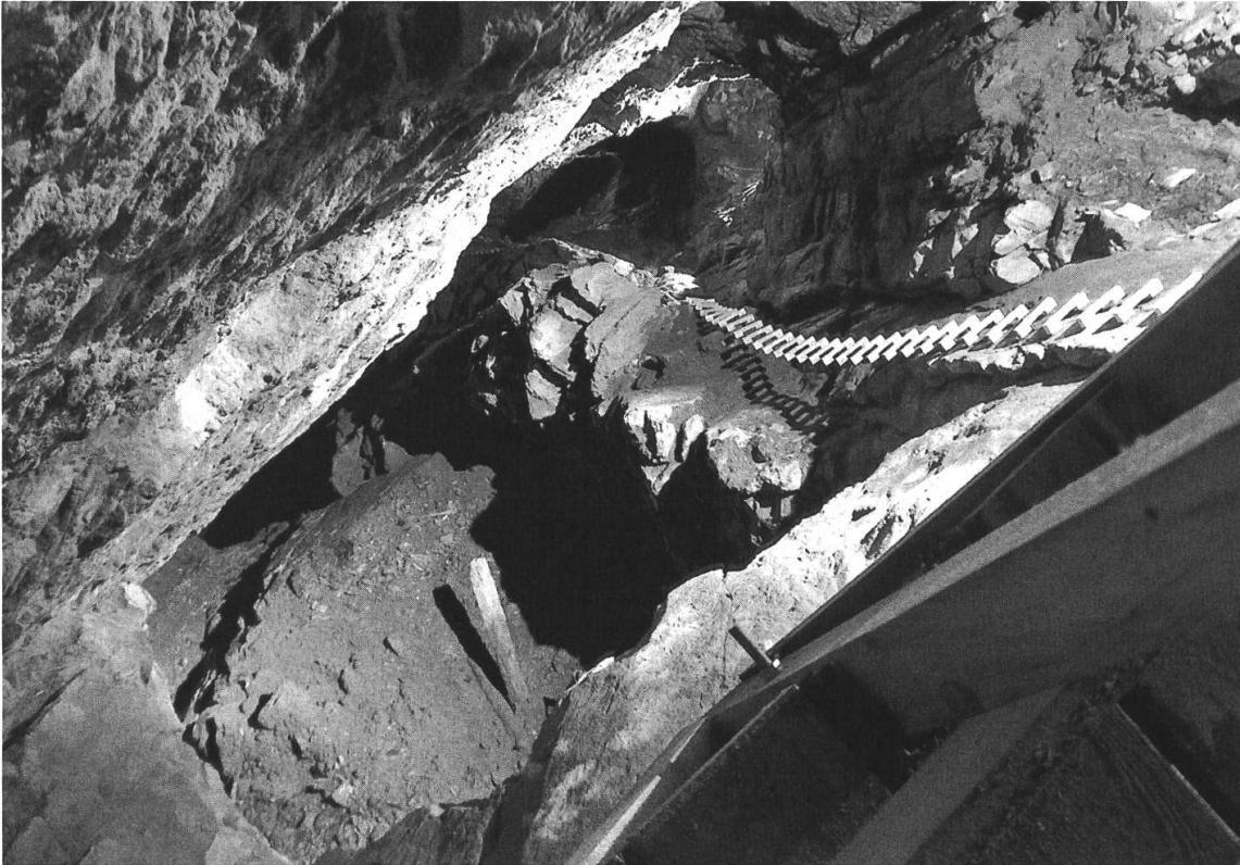
Abb. 3 : Blick von der Brücke in die Tiefe des Schachtes mit Strickleiter
