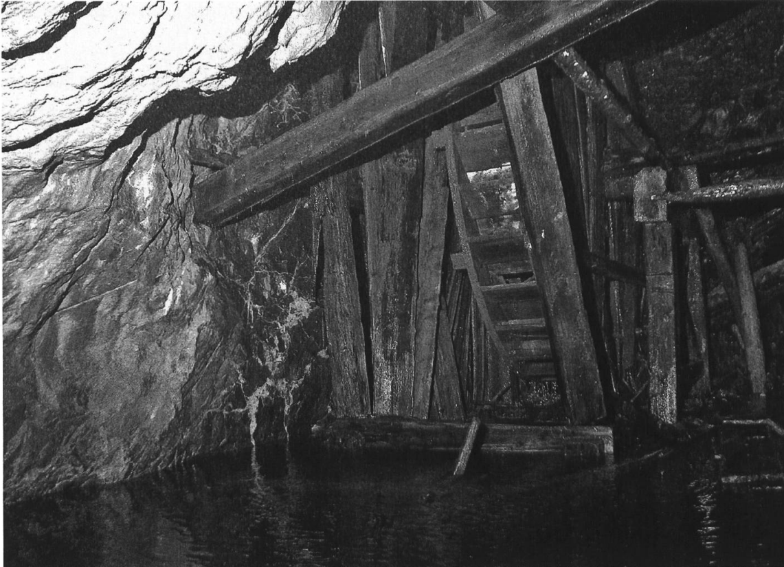
Abb. 10 : Wasserrad im Andreasstollen
