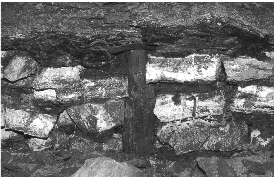
Abb. 14: Eingeschütteter Holzstempel in einem Abbauschlitz
