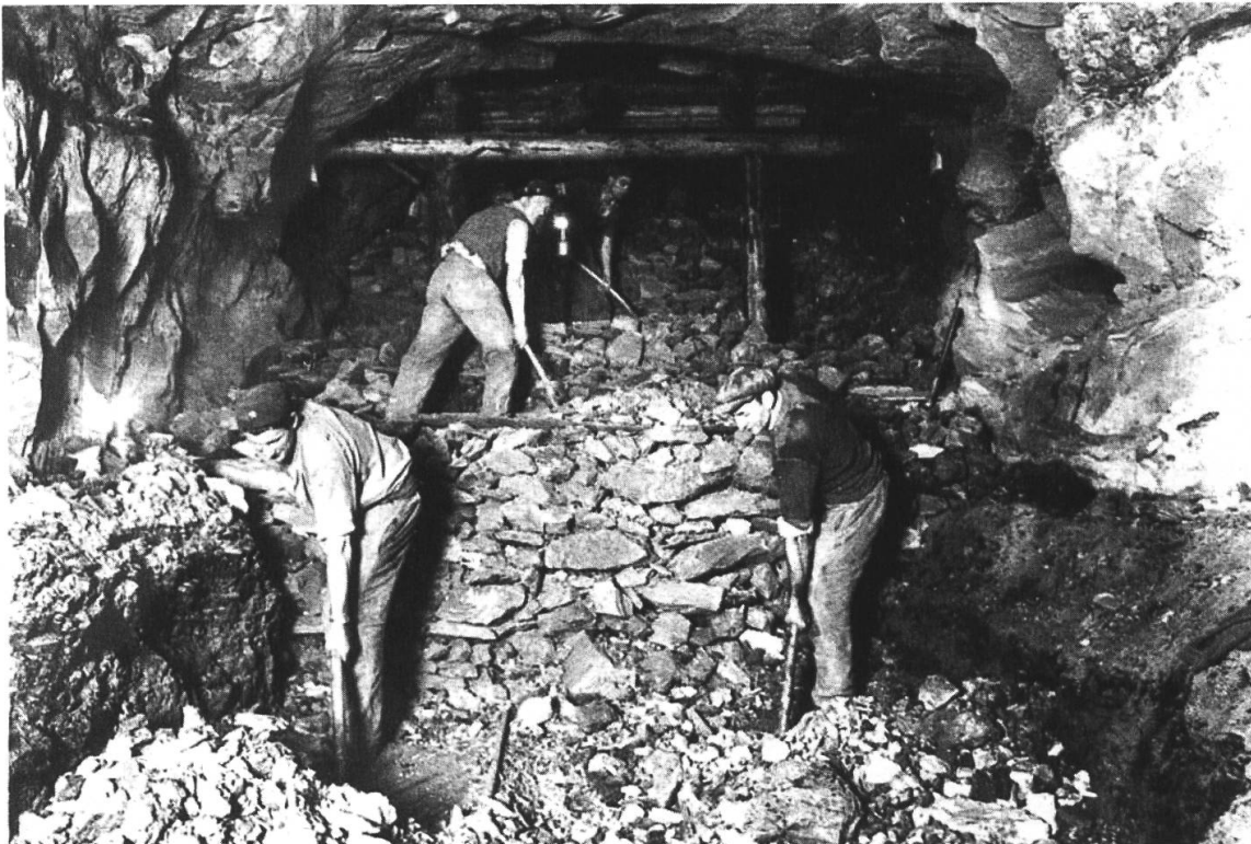
Abb. 7: Versatzarbeiten
