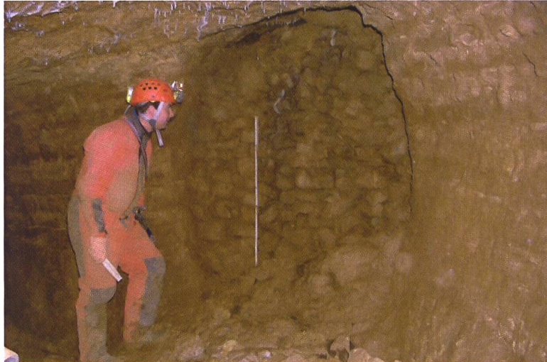
Fig. 27 : Empilement de stériles bouchant une recoupe dans la mine de Oye-et-Pallet (Doubs). Cliché M. Cottet et M. Bôle.
