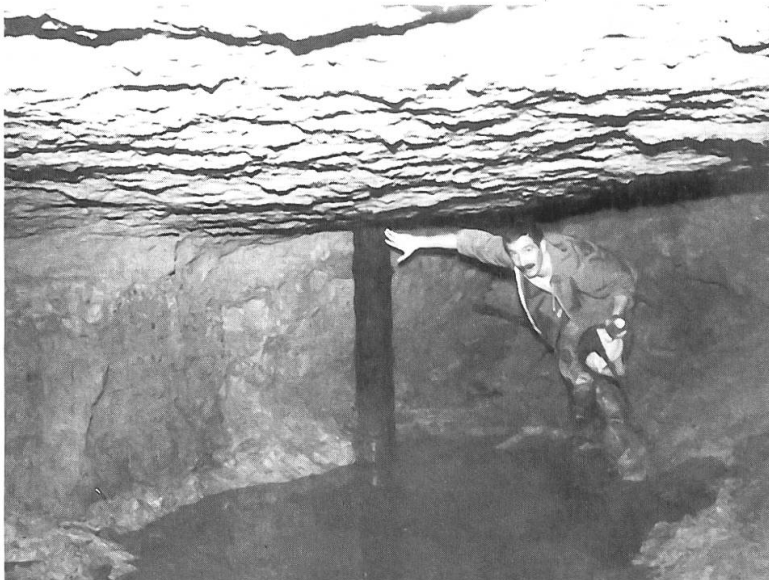
Fig. 19 : Exploration de la mine de Métabief – printemps 1964. Vue d'un front de taille avec un étai en bois vertical.
