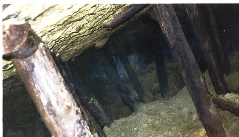
Fig. 11 : Détail des boisages dans la mine des Seignots (Les Longevilles/Doubs). Cliché C. Jacquemin-Verguet.
