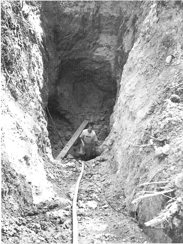
Fig. 13 : Vue de l'accès creusé à la pelle mécanique en 2000 à la «Borne 11» (Les Longevilles/Doubs). Tout en bas, on aperçoit la voûte d'une galerie comblée. Cliché C. Jacquemin-Verguet.
