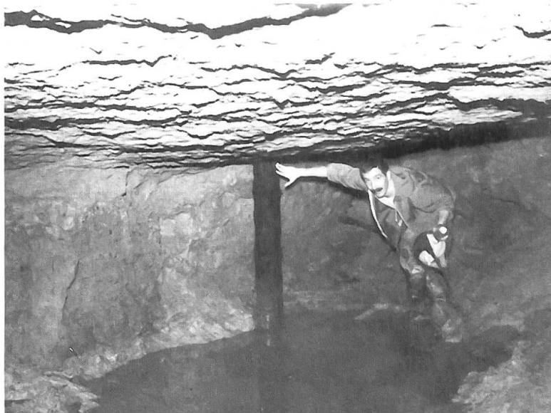
Fig. 19 : Exploration de la mine de Métabief – printemps 1964. Vue d'un front de taille avec un étau en bois vertical.
