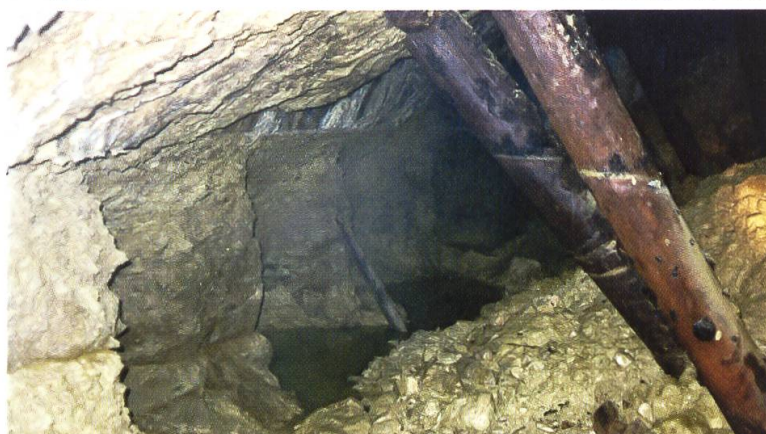
Fig.10: Chambre d'exploitation avec soutènement en bois dans la mine des Seignots (Les Longevilles/Doubs) après pompage. Cliché C. Jacquemin-Verguet.
