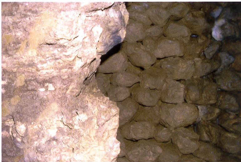
Fig. 25 : Emplacement de lampe dans la paroi de la mine de Oye-et-Pallet (Doubs). Cliché M. Cottet et M. Bôle.
