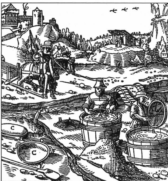
Abb. 7: Bohnerzwaschen. Holzschnitt aus: Georg Agricola, Basel 1556.
