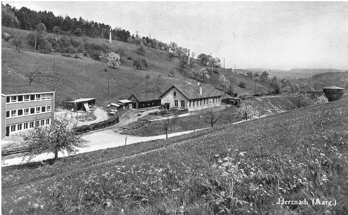
Abb. 4: Aufnahme des Bergwerks von ca. 1960. Links das Bürogebäude, in der Mitte die Werkstätte, rechts der Silo. Erkennbar ist auch die Erzseilbahn nach Frick.
