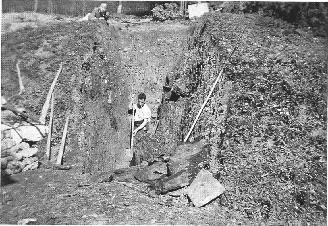
Das Flöz liegt über drei Meter tief.
