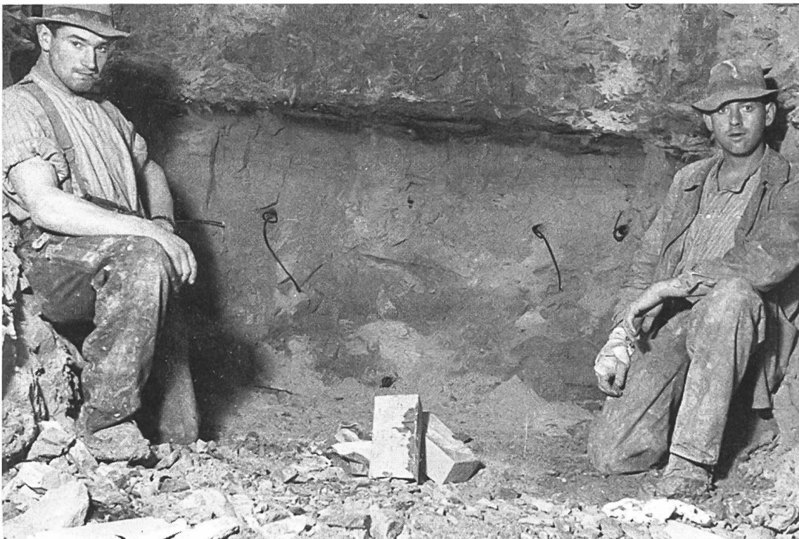
Abb. 25: Die Bohrlöcher sind geladen und sprengbereit.
