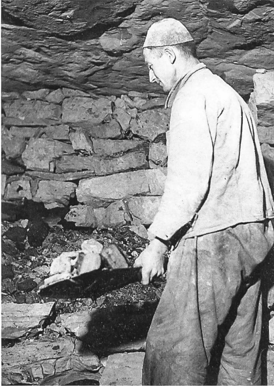
Abb. 26: Arbeiter beim Einbringen der Versatzmauern. Diese verantwortungsvolle Aufgabe diente der Sicherheit im Stollen. Die Schlusssteine wurden jeweils eingehämmert.
