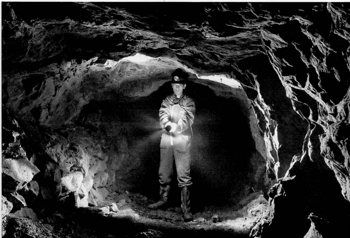
Abb. 56: Typischer, mannshoher Stollenquerschnitt in einem Transportstollen. Das Bild stammt aus dem Richtstollen, kurz nach der Biegung. Foto: H. Vontobel, 2001.
