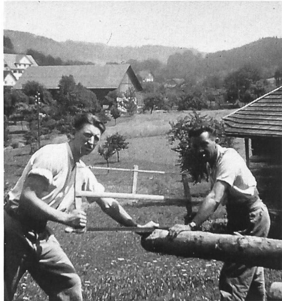
Abb. 17: Bergwerksarbeiter richten Stempel für die Holzeinbauten in den Stollen vor.
