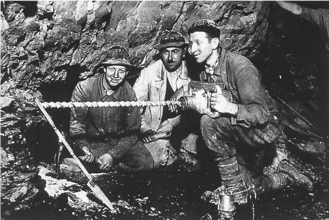
Abb. 24: Elektrischer Bohrer (Schlangenbohrer mit Vidiakronen). Für ein 1.2 Meter tiefes Loch benötigte man im Mergel 5 bis 8 Minuten, im Süßwasserkalk bis 30 Minuten. Im Südteil wurde im Abbau auch ein mit Pressluft betriebener Abbauhammer benutzt.
