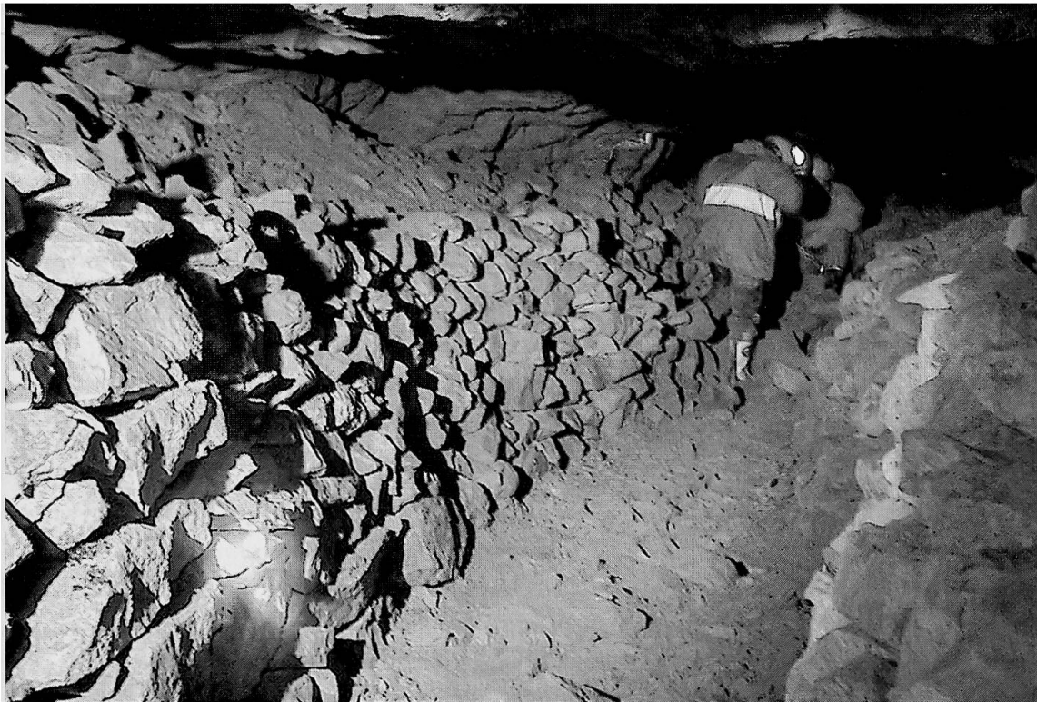
Abb. 55: Versatzmauern im ältesten Bereich des Bergwerks. Foto: R. Vogt, 2001.
