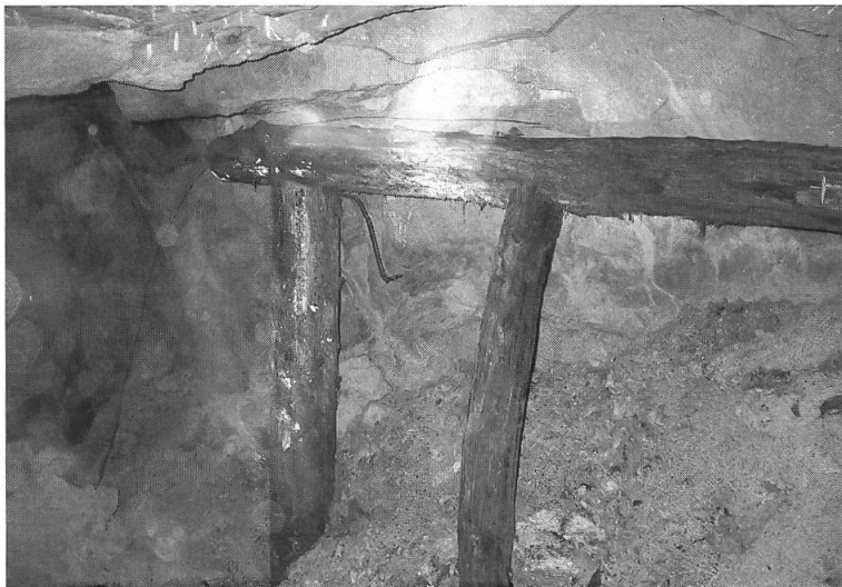
Abb. 58: Morsche Holzeinbauten «stützen» lockere Felspartien im Richtstollen, ca. 100 Meter im Innern des Berges. Foto: R. Vogt.
