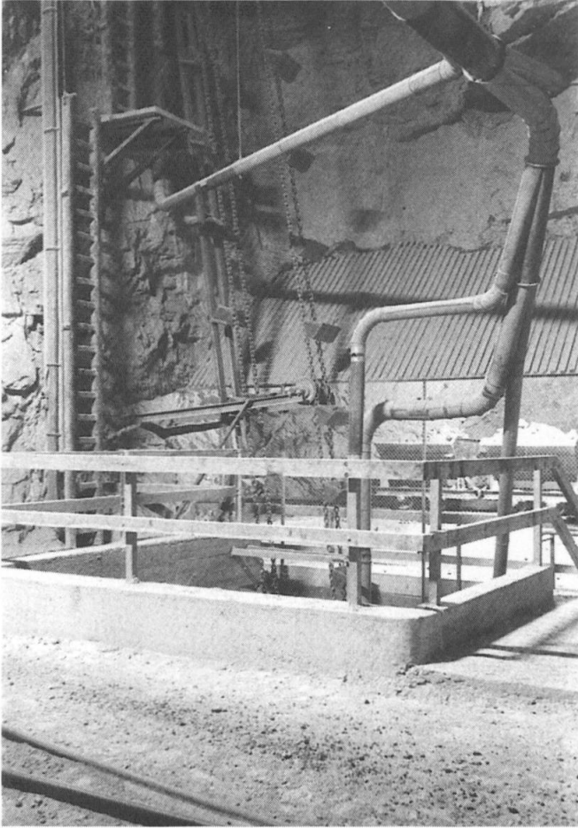
Abb. 4: Brecher mit Elevator zur Silo Beschickung (1952).
