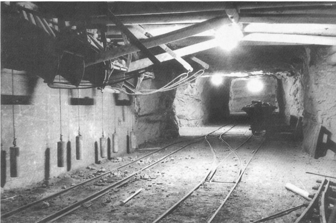
Abb. 5: Siloanlage im Hauptförderstollen 1957
