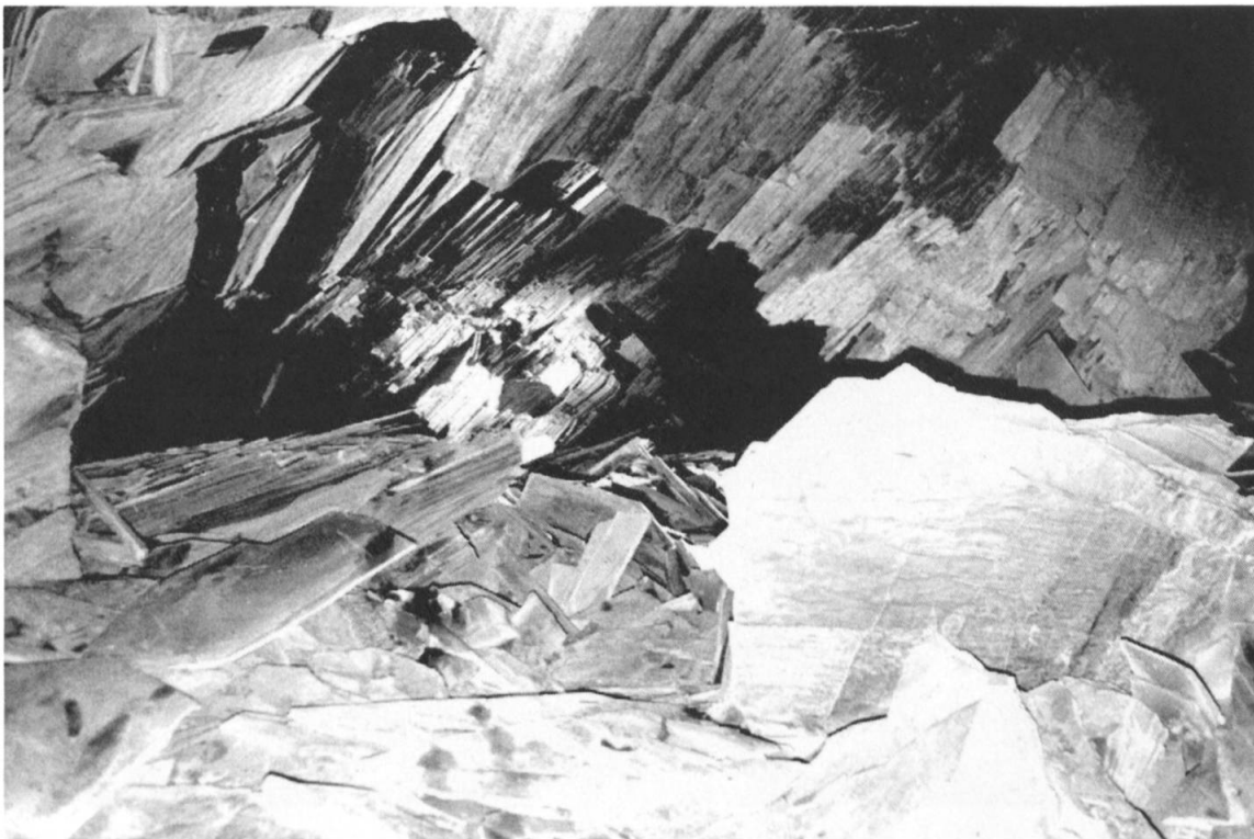
Im Landesplattenberg Engi wurden während Jahrhunderten Schieferplatten abgebaut, so dass riesige, faszinierende Hohlräume entstanden (Foto HP. Stolz).
