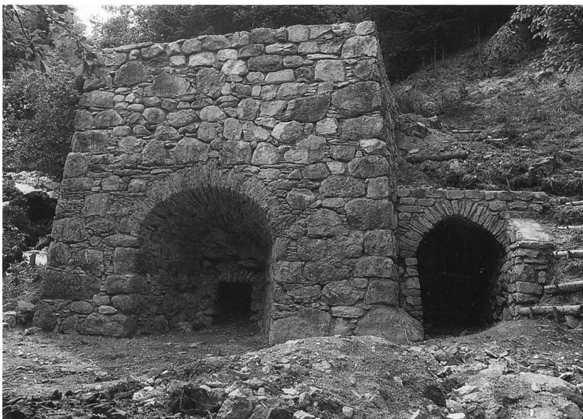
Abb. 3: «Eisenwerk am Stein» – der sanierte und gesicherte Hochofen.
