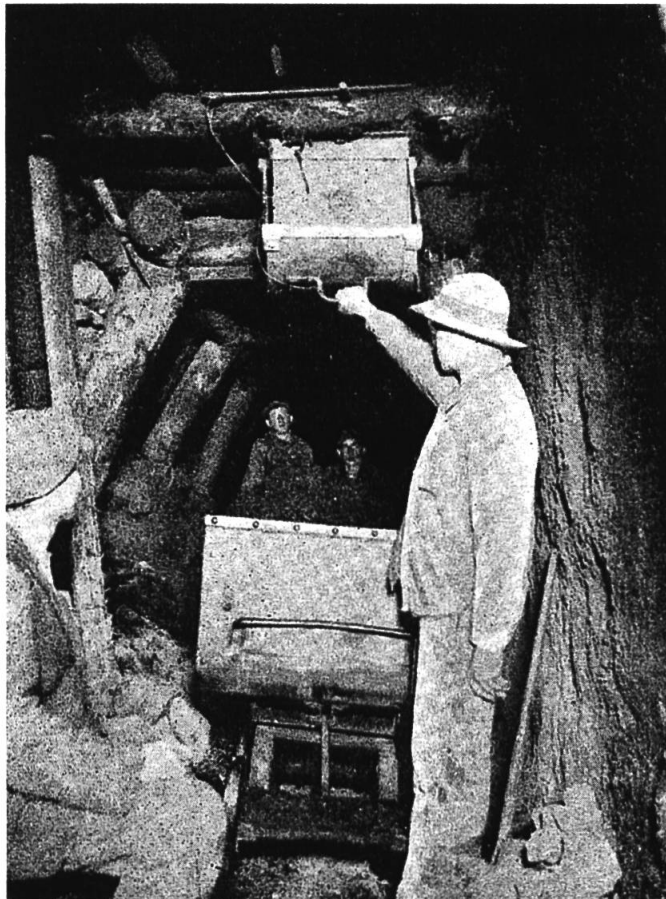
Abb. 22: Stollenausbau. Schiebeverschluss des Füllrohrs. Ein Arbeiter in Arbeitskleidung (Foto aus Beitr. Geologie der Schweiz, geotechn. Serie, Lief. 12, 1925)
