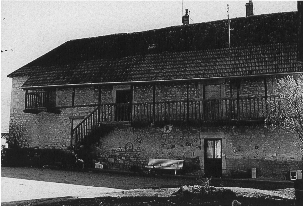
Fig. 5: Forge de Montagney. Maison du directeur. Façade nord. (Photographie : M-J Giet).
