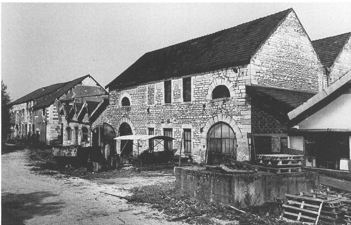
Fig. 2 : Forge de Pesmes (Haute-Saône) : vue des bâtiments des hauts fourneaux encadrant l'ancienne forge dont la toiture (à sheds actuellement) a été très remaniée au XX e siècle. Cliché Inventaire Général, Yves Sancey.
