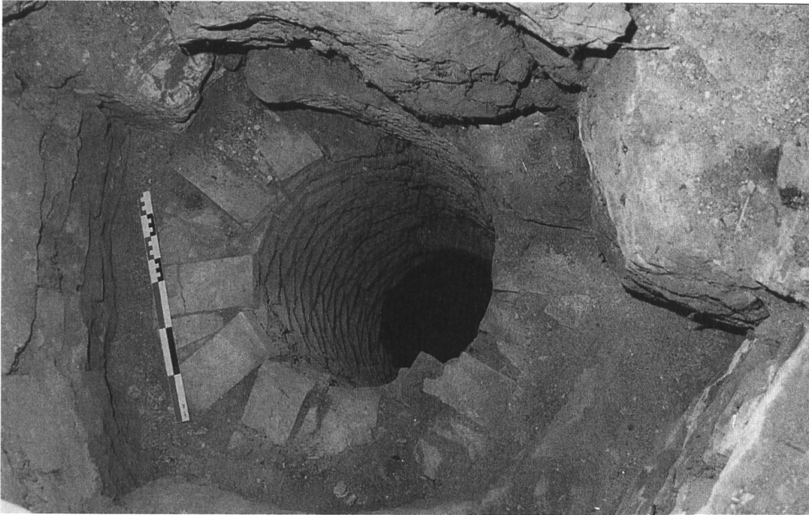
Fig. 10 : Haut fourneau de Montagney – UA103. Orifice destiné à la récupération de l'air chaud pour la ventilation. (Photographie : Denis Morin).
