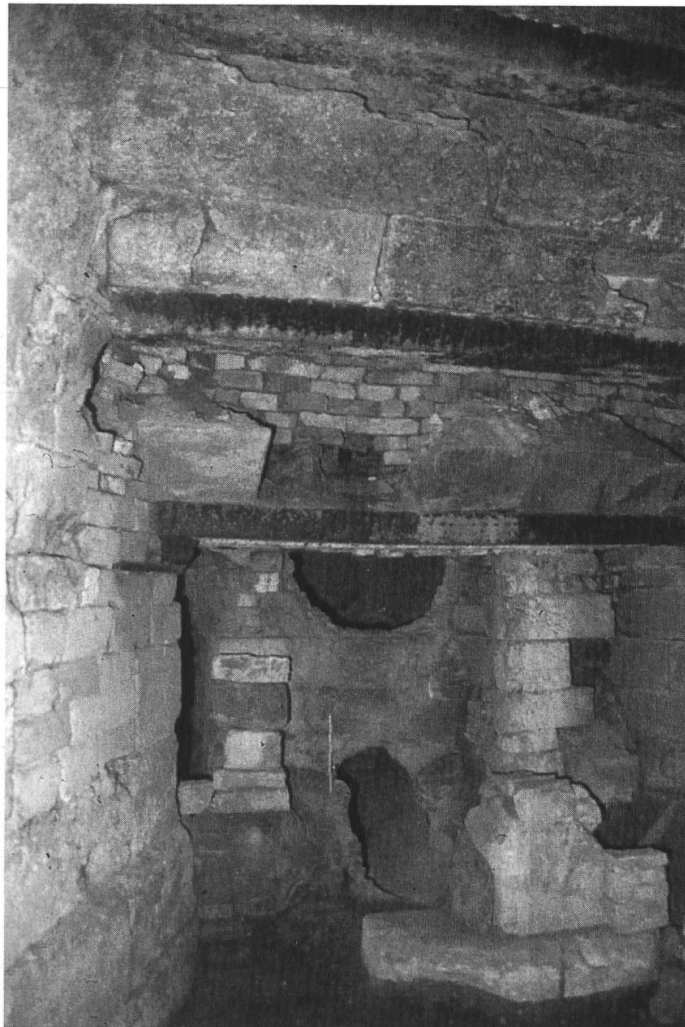
Fig. 11 : Haut fourneau de Montagney – UA102. Halle et trou de coulée. (Photographie : Denis Morin).
