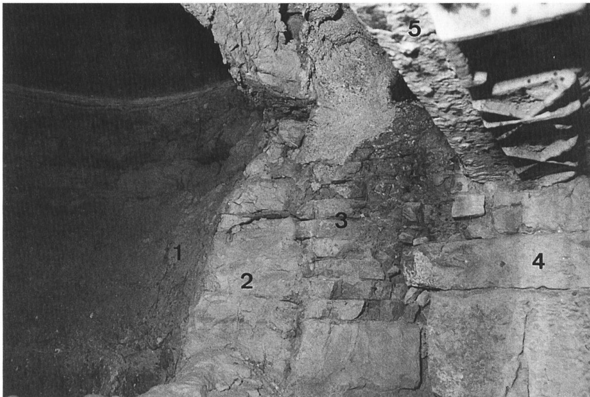
Fig. 6 : Haut fourneau de Montagney – UA102. Vue stratigraphique à hauteur des étagères montrant les techniques de maçonnerie de la cuve. 1 Creuset. – 2 Chemise interne en pierres calcaires 3 Remplissage en briques réfractaires – 4 Maçonnerie appareillée – 5 Marâtre : gueuse de fonte numérotée utilisée comme voussoir. (Photographie : Denis Morin).
