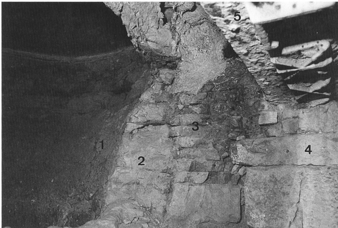
Fig. 6 : Haut fourneau de Montagney – UA102. Vue stratigraphique à hauteur des étales montrant les techniques de maçonnerie de la cuve. 1 Creuset. – 2 Chemise interne en pierres calcaires 3 Remplissage en briques réfractaires – 4 Maçonnerie appareillée – 5 Marâtre : gueuse de fonte numérotée utilisée comme voussoir. (Photographie : Denis Morin).
