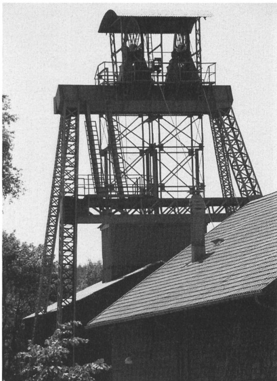
Fördergerüst des Ottiliaeschacht in Zellerfeld.
