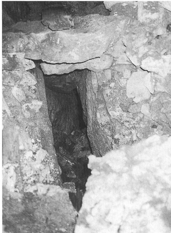
Fig. 7: Ein Schacht folgt dem Flöz mehrere Meter in die Tiefe.
