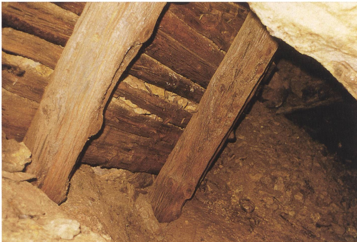
Fig. 10: Zimmerungen am Ende der Grube I.
