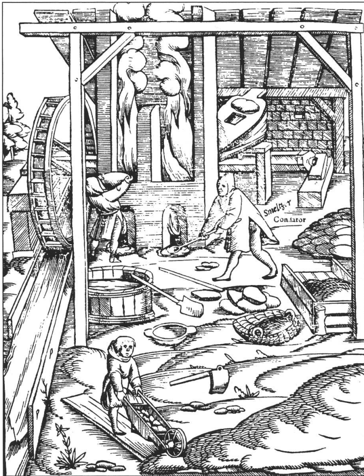
Fig. 23: Schmelzanlage (mit Wasserradantrieb des Blasbalges).
