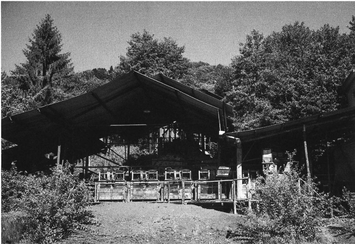
Fig. 12: Impianto di Beredino della società Mines de Costano, nel 1963. (Foto E. Steiger).
