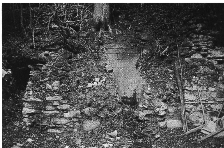
Fig. 16: Bocca di scarico del forno di arrostitimento del Monte Torri. (Foto E. Steiger).
