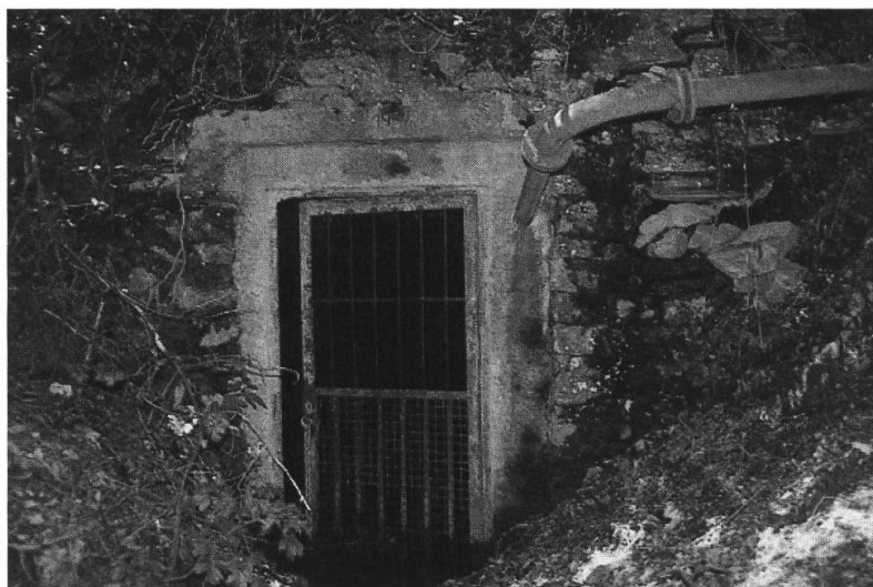
Fig. 11: Entrata della miniera La Costa a Sessa, come si presenta oggi. (Foto E. Steiger).
