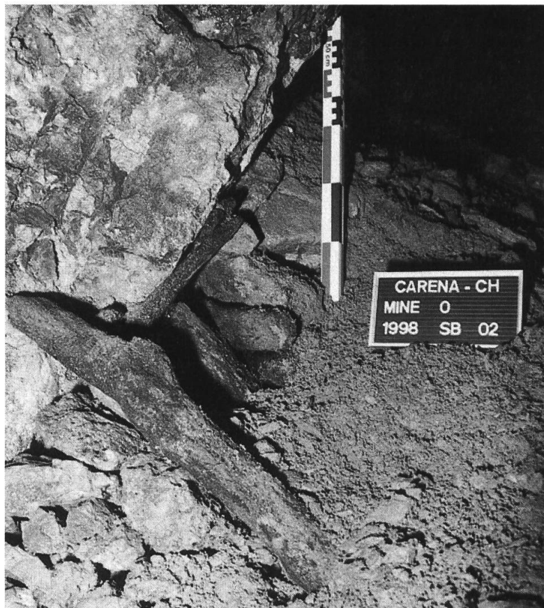
Fig. 7 : Carena TI. Mine Christian I. Hourdage. Barrage mixte (billes et planches) construit au pied d'une taille en gisement penté en vue de retenir les remblais et murette en stériles. (Photographie : D. Morin).
