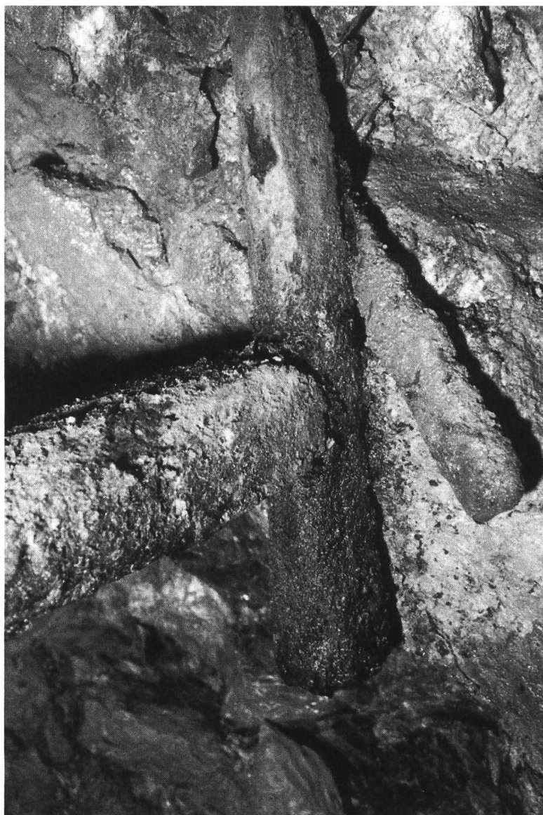
Fig. 10 : Carena TI. Mine Christian I. Boisage latéral. Bille rivée au toit sur cale double. Assemblage à gorge de loup. (Photographie : D. Morin).
