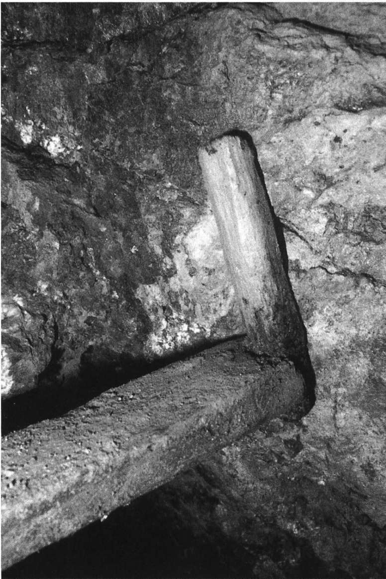
Fig. 9 : Carena TI. Mine Christian I. Boisage latéral. Bille rivée au toit sur cale simple. Assemblage à gorge de loup. (Photographie : D. Morin).
