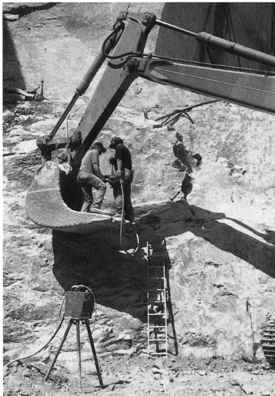
Bohren von Sprenglöchern im harten Tessinergneis (Foto R. Kündig).
